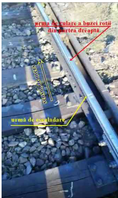
Fig. nr.4 - Urmele de deraiere pe acul curb al schimbătorului de cale nr.31
