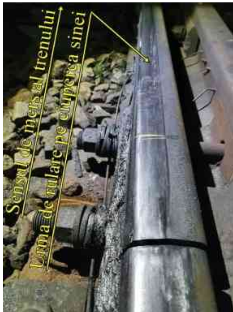
Foto nr.1 - urma de rulare pe șina de legătură de la călcâiul acului curb
