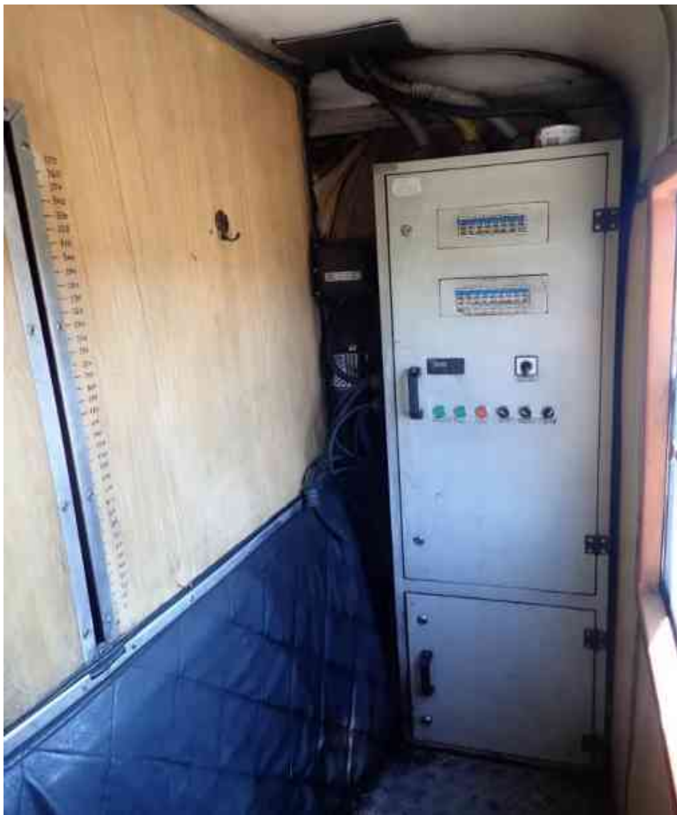
Foto nr.9–Pозиționarea tabloului electric și a indicatorului „sticlă de nivel” combustibil
