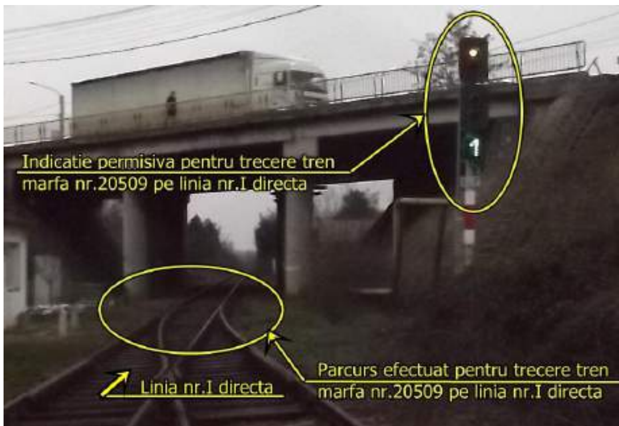
Foto nr.1 Poziția acelor macazului schimbătorului de cale nr.2
