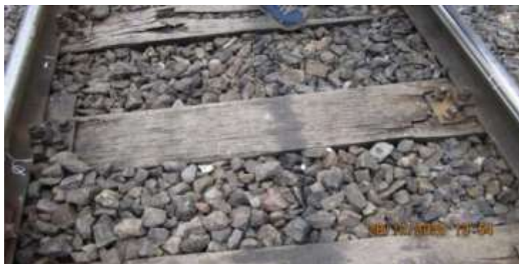
Foto nr.4 Prima urma de lovire a bulonului vertical
