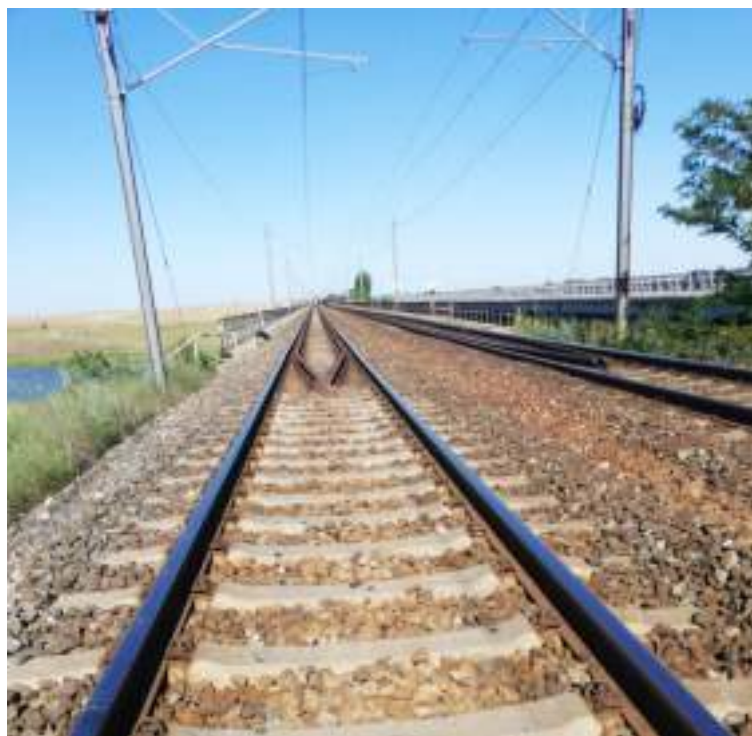
Foto nr.1 - locul producerii accidentului, capătul podului și contrașinele acestuia
