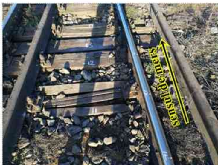
Fig. nr.5 – starea tehnică a traverselor
