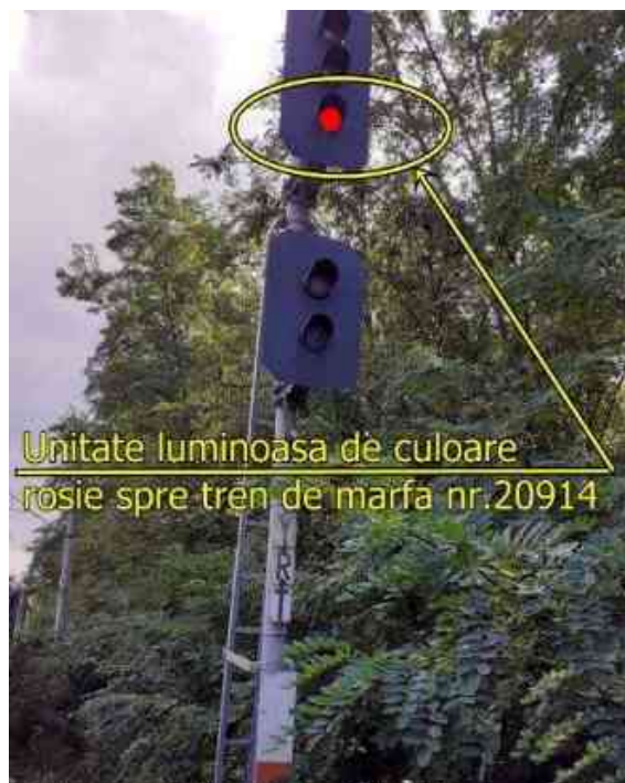
Foto nr.1 Semnalul luminos de ieșire de ramificație YRT din halta de mișcare Gura Motrului
