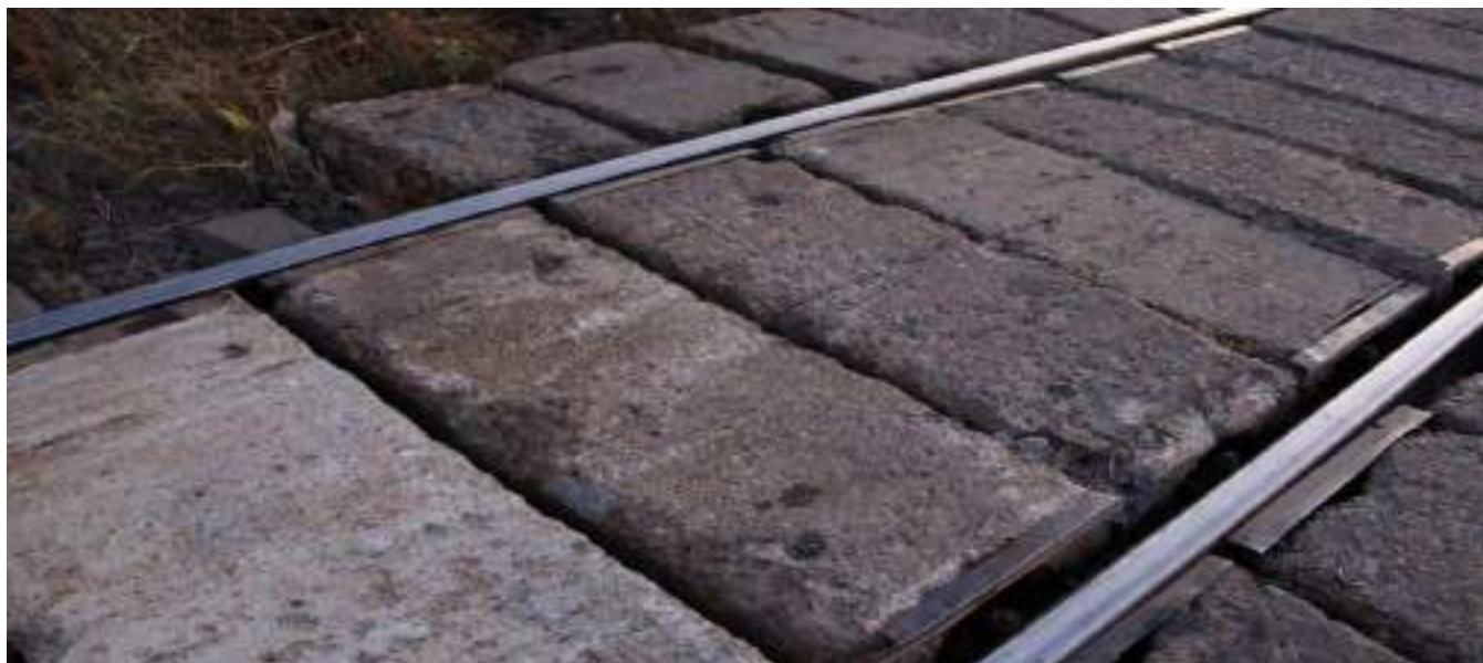
foto 3: urme de frecare pe suprafața superioară a ultimelor 3 dale precum și platbanda metalică lipsă la antepenultima dală din cuprinsul trecerii la nivel
