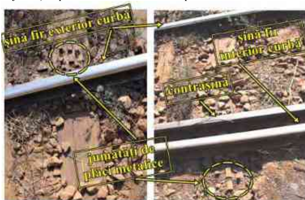
Foto nr. 4 – jumătăți de plăci metalice montate înspre exteriorul căii pe capetele traverselor
