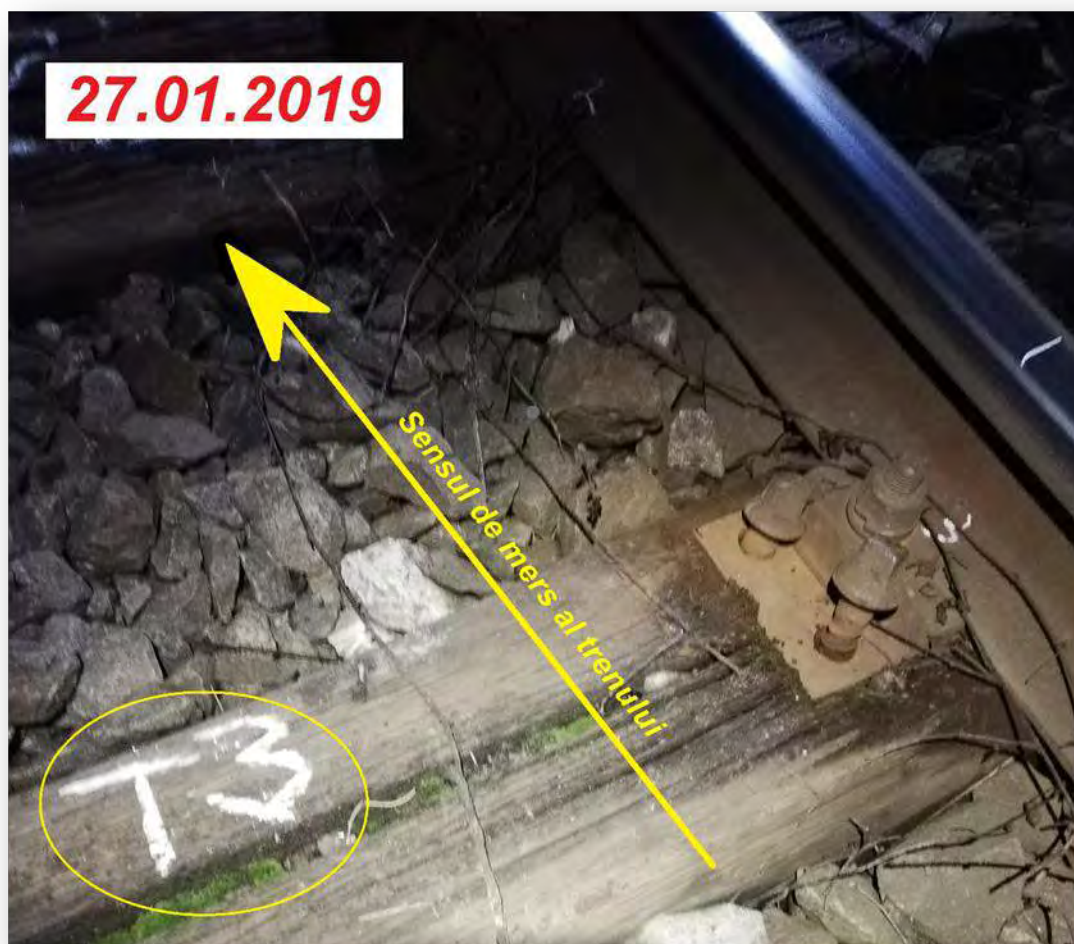
Foto nr.5 – Traversa necorespunzătoare T3. Starea prinderii șină-traversă
