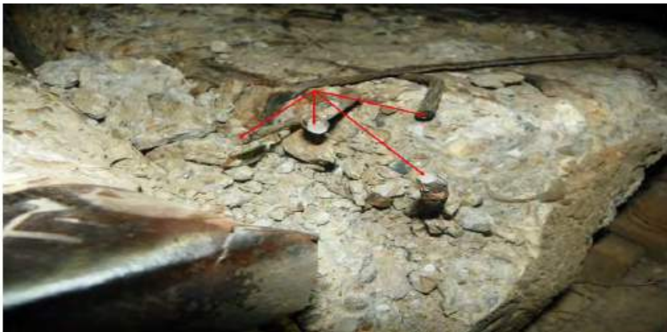
foto 4: secțiunea de rupere a armăturilor pe zona desprinderii platbandei metalice
