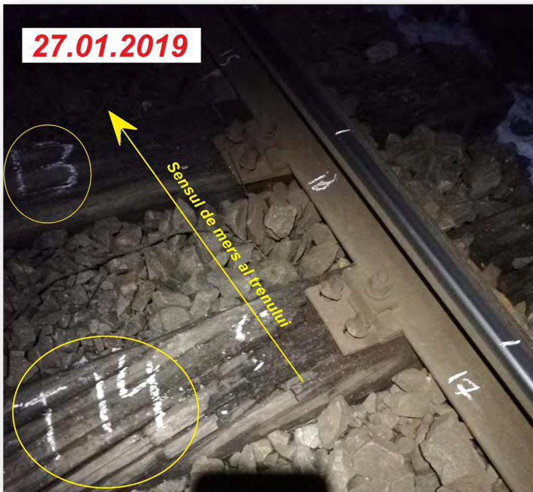
Foto nr.6 -Traversele necorespunzătoare T13 și T14. Starea prinderii șină-traversă
