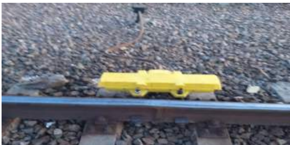
Fotografia nr. 5 – Inductorul înlocuit
