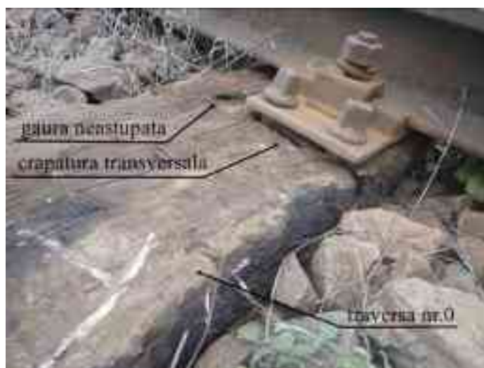
Foto nr.5 – traversa nr. 0 (detaliu la interiorul firului exterior al curbei)
