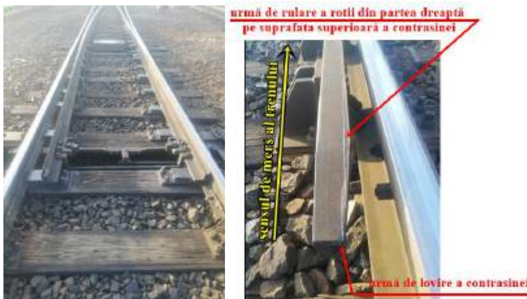
Fotografia nr. 3 -urmele lăsate pe schimbătorul de cale nr.26 de roțile deraiate
