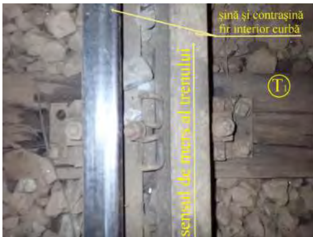
Foto nr.3 - traversa necorespunzătoare T 1
