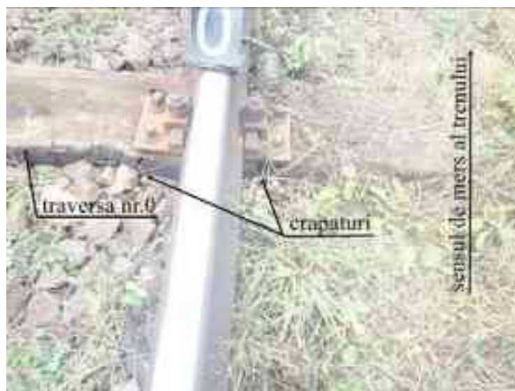
Foto nr.4 – traversa nr. 0 (detaliu fir exterior curbă)
