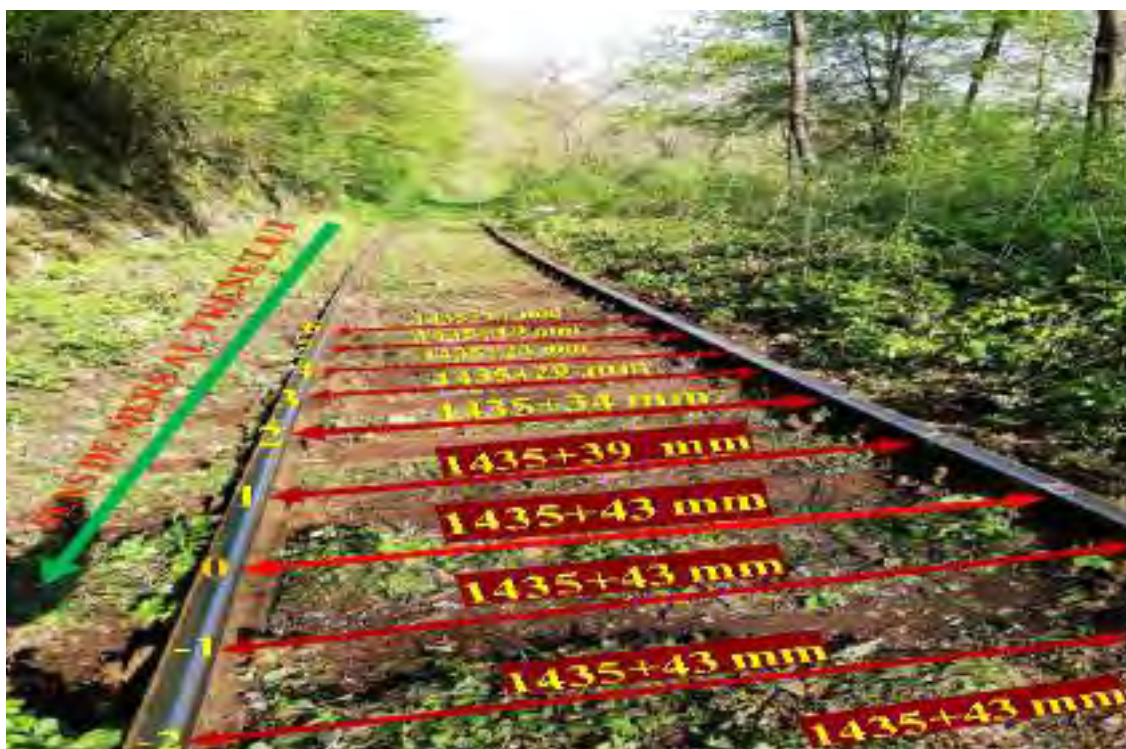
Fotografia nr. 2: Zona producerii deraierii. Valorile ecartamentului în picheții -3/6
