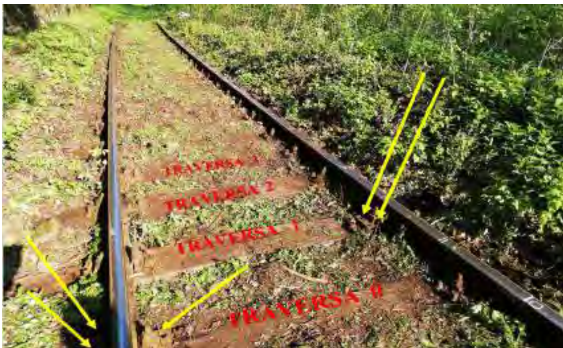
Fotografia nr. 5: Starea tehnică a traverselor T0 , T1, T2, T2 și T3 la firul interior al curbei
