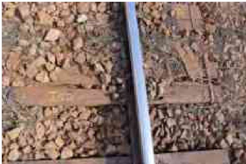
Foto nr.5 – traversă necorespunzătoare
