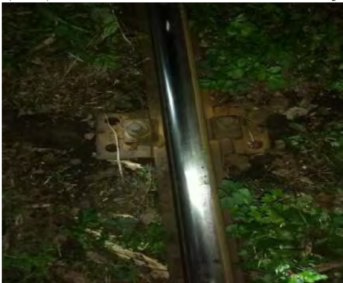
Fotografia nr. 3: Starea tehnică a traversei T_0 - la firul exterior al curbei
