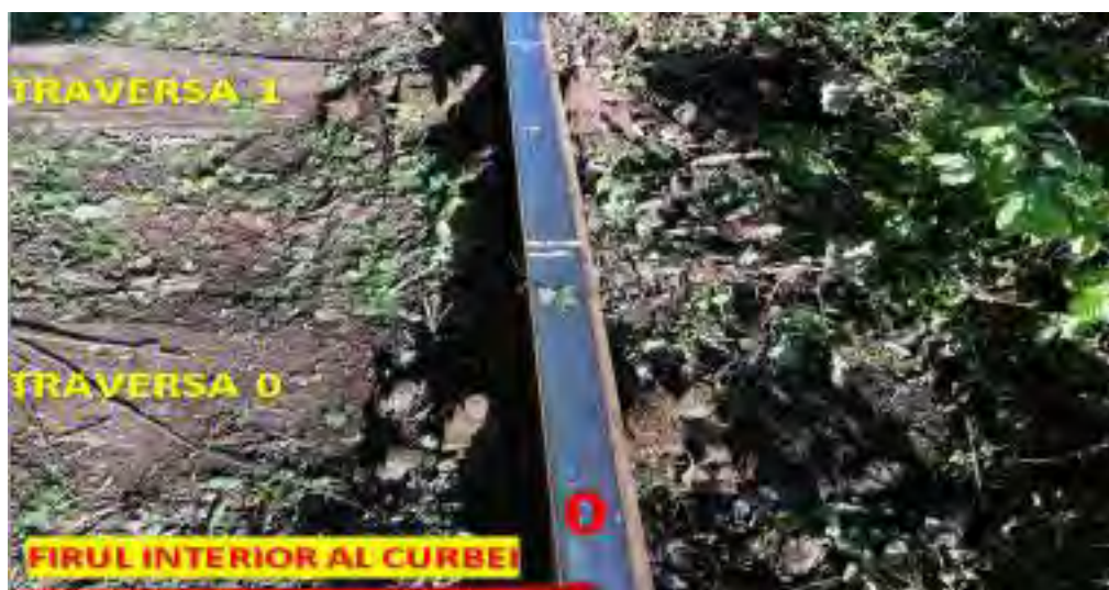
Fotografia nr. 4: Starea traverselor T_0 și T_1 - la firul interior al curbei
