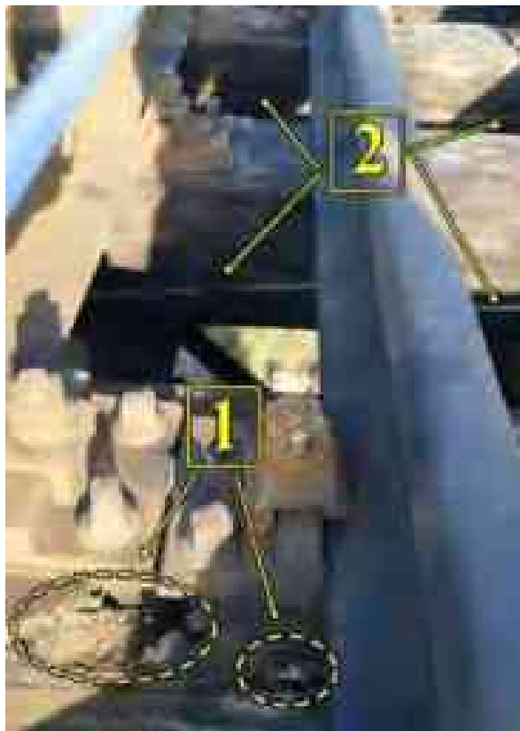
foto nr. 15 - 1.- putrezirea traversei sub plăcile metalice 2.- traverse cu crăpături longitudinale
