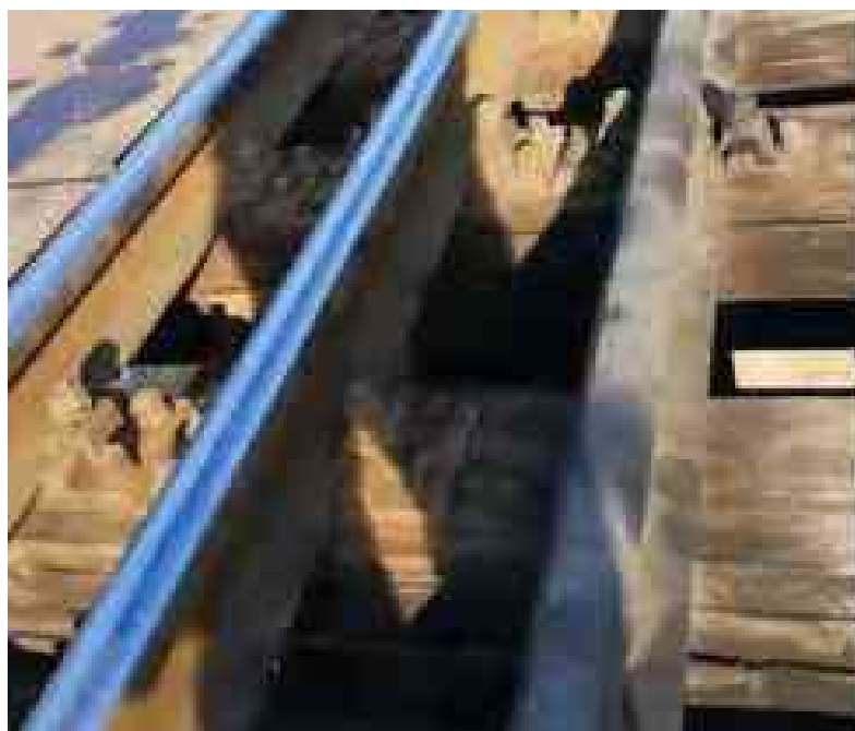
foto nr. 16 - traverse cu crăpături longitudinale
