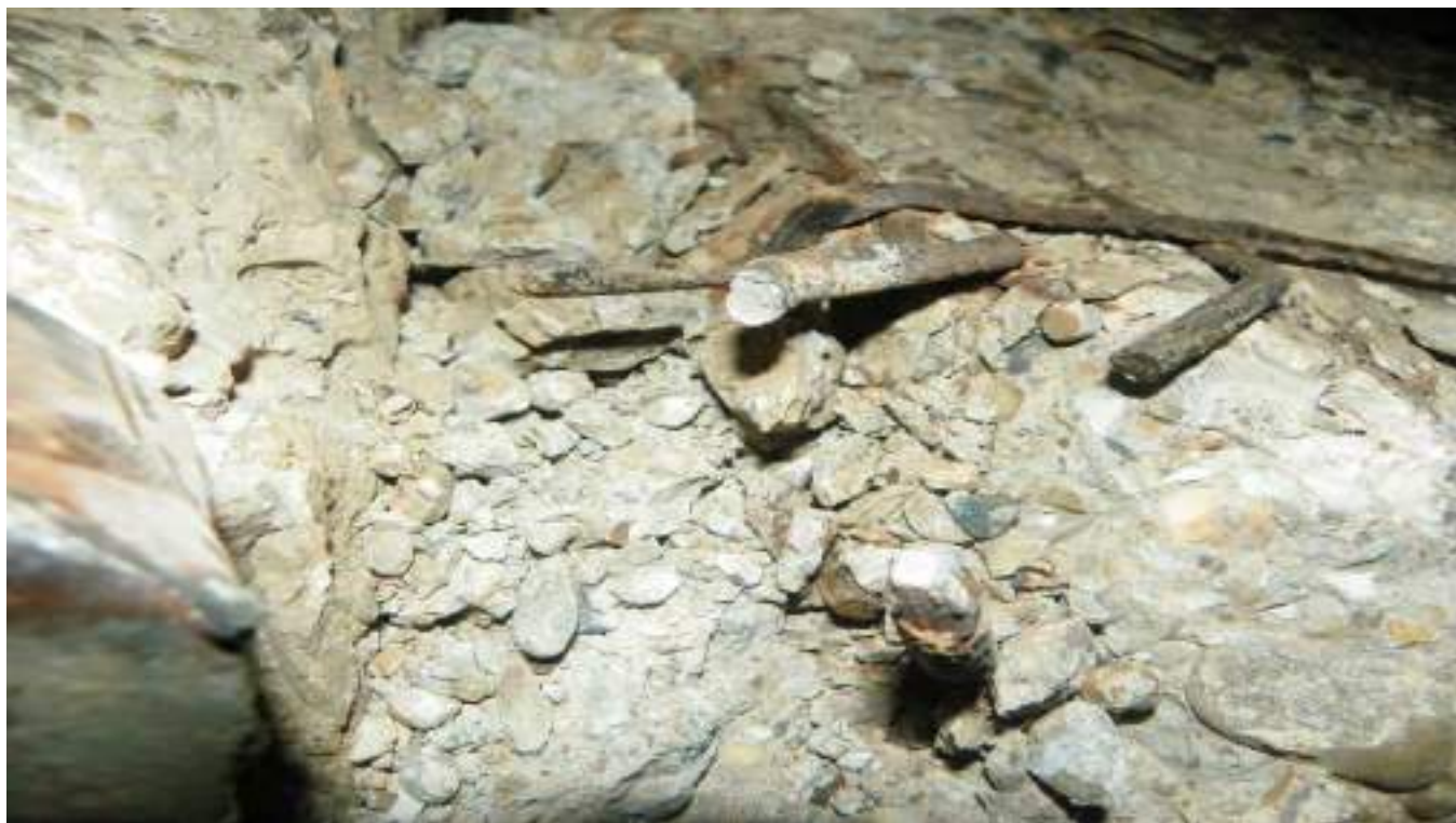
foto 11: starea secțiunii de rupere a armăturilor aflate la capătul dalei dinpre Roșiori, după impact
