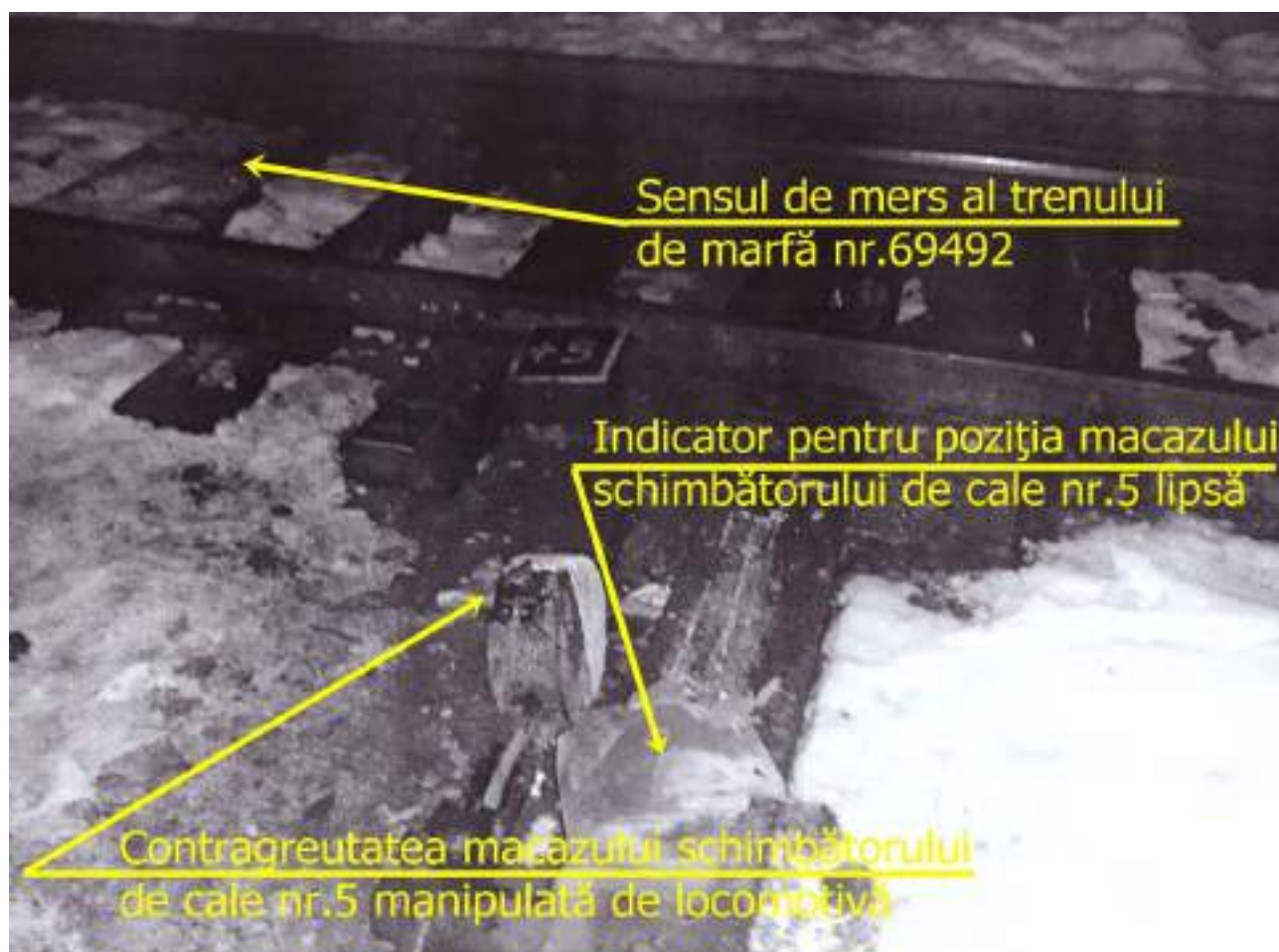
Fig.6 Aparatul de manevrare al macazului schimbătorului de cale nr.5
