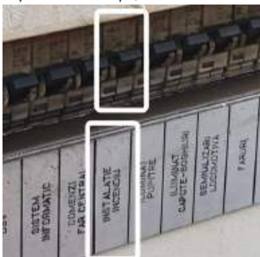
Imaginea 5 - siguranța electrică de la instalația de detectare a incendiilor la compartimentele motor, era nedeclanșată;
