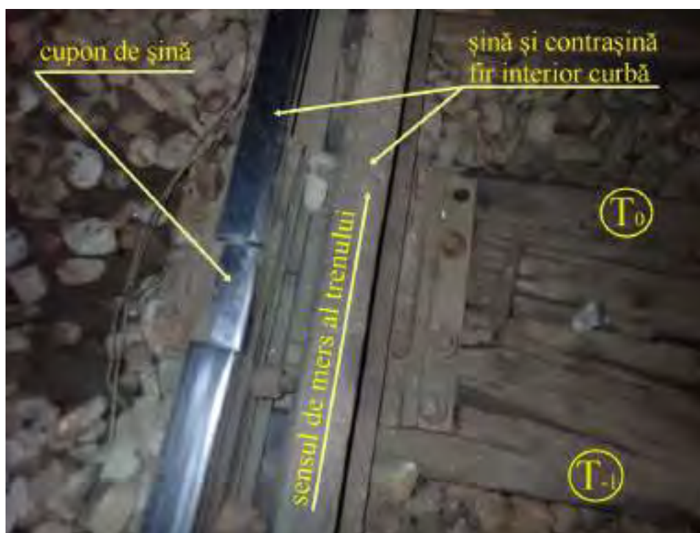
Foto nr.4 - traversele necorespunzătoare T 0 și T -1 și modul de alcătuire al joantei pe firul interior al curbei
