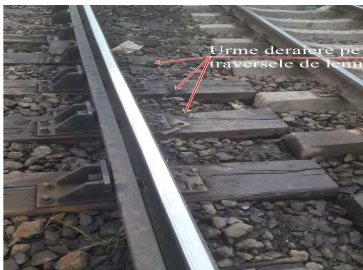
Foto nr.3 – urmele de lovire a traverselor de lemn de către roțile deraiate
