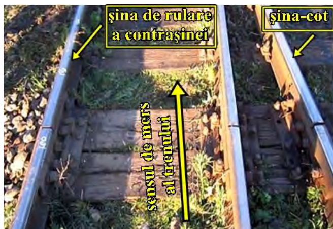
foto nr.8 - direcția,, abatere” traversele din zona joantei de vârf a inimii
