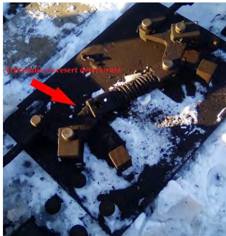
Fig. 4 DAM al macazului nr.13, deteriorat
