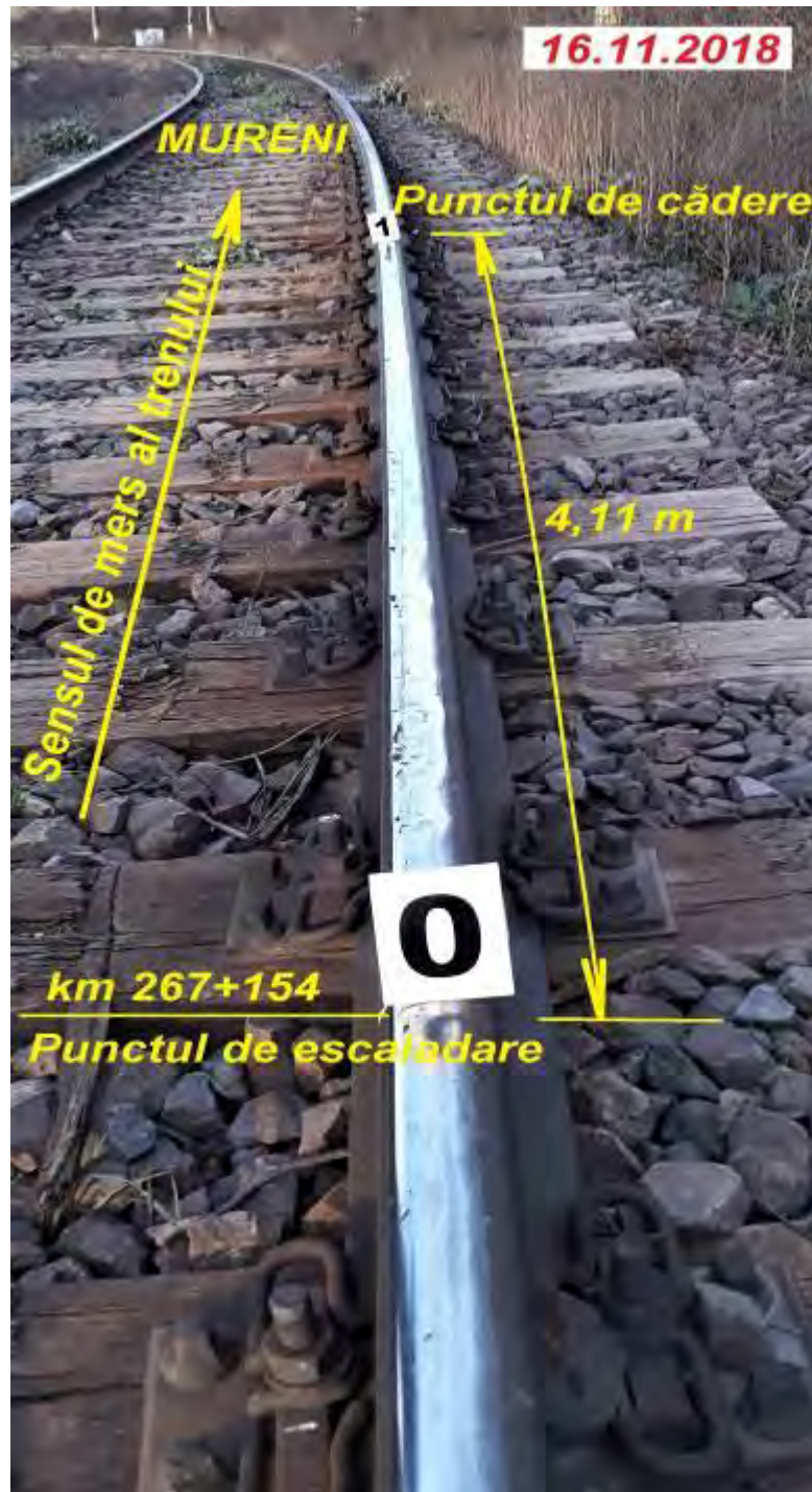
Foto nr.5 – Punctul de escaladare „0” și punctul de cădere „1” a roților din dreapta osiilor nr.1 și 2
