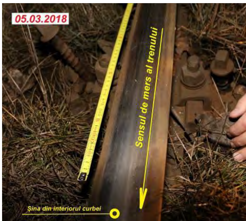
Foto nr. 13 – Starea prinderii (șina din interiorul curbei)
