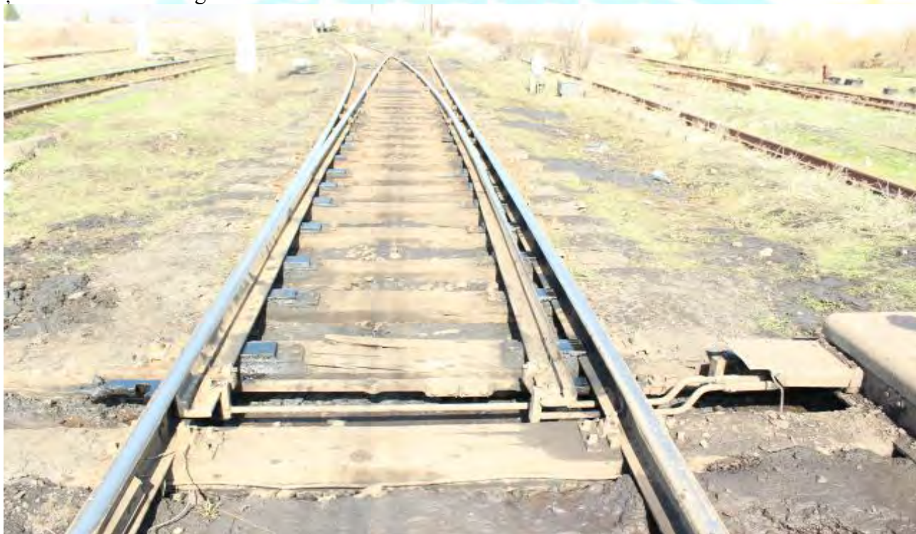
foto 3 – schimbătorul de cale nr. 24 după producerea deraierii
