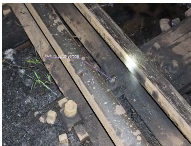
foto 5,6 - lovituri ale materialului metalic de către roțile deraiate
