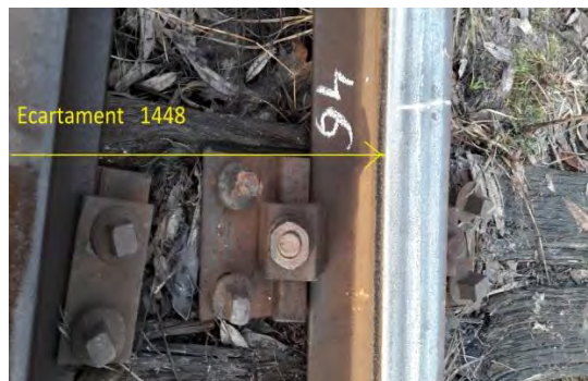
Imaginea 18 - Traverse putrede în dreptul punctelor de măsurare 36, 37, 43, 44,45,46
