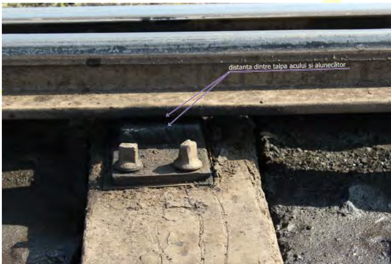
foto 8 - poziția acului curb față de alunecători
