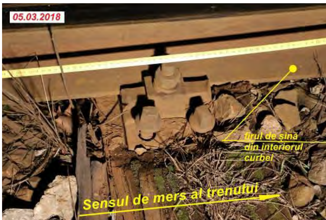
Foto nr.12 – Locul de cădere între firele căii (șina din stânga) – cu tirfoane ce se puteau scoate cu mâna
