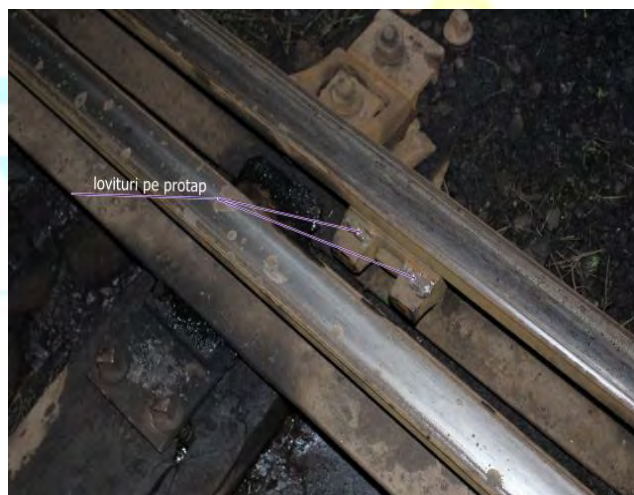
foto 5,6 - lovituri ale materialului metalic de către roțile deraiate
