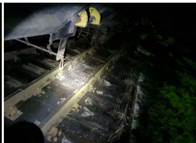
foto 9, 10, 11, 12 - starea prisme de piatră spartă pe zona producerii accidentului
