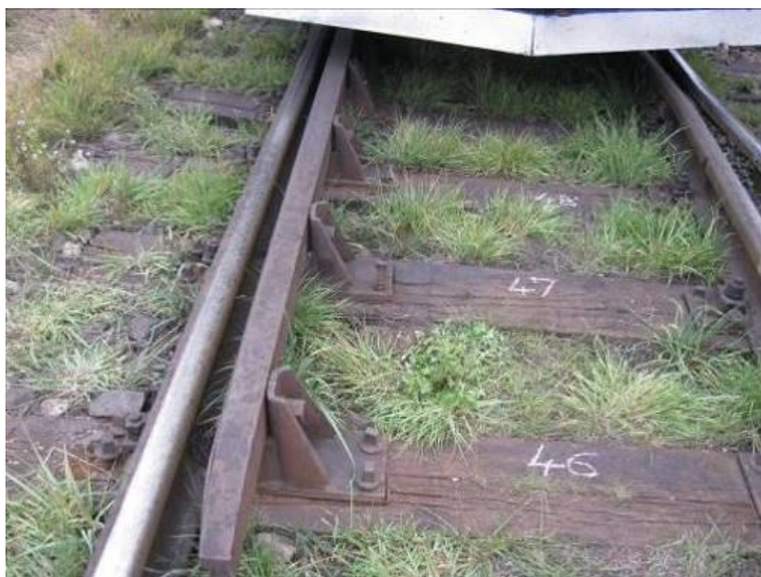
Foto nr.5 – Numerotarea traverselor pe schimbătorul de cale nr.59A
