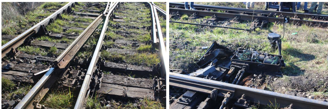
Foto 16: parte din pagubele produse la schimbătorul de cale nr. 3
