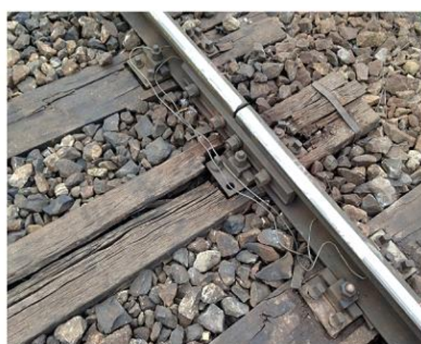
traversa nr.1 de la joanta aflată înaintea punctului „0” - detaliul A
