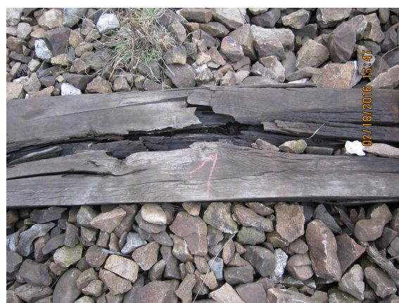
foto nr.2: Traverse necorespunzătoare de pe zona deraiată
