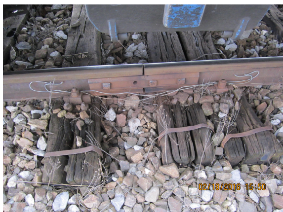
foto nr.2: Traverse necorespunzătoare de pe zona deraiată
