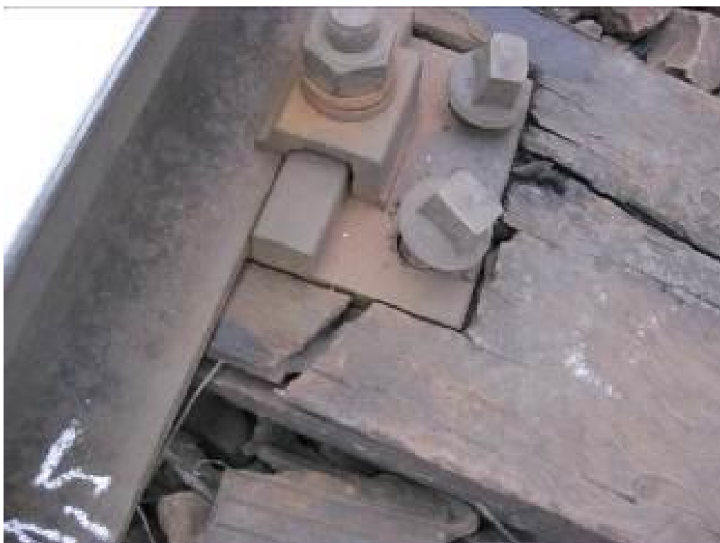
Foto nr.17 - Detaliu traversa B, partea stângă față de senul de mers al trenului
