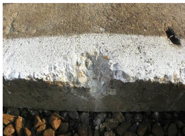
Fig.6 Prima dală a pasajului de trecere pietonal de la km 285+950 lovită.
