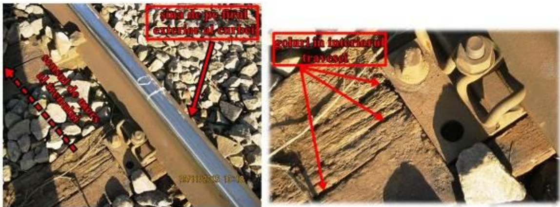
foto nr.7 - traversa din punctul 0 - capătul din partea dreaptă (firul exterior al curbei) și detaliu
