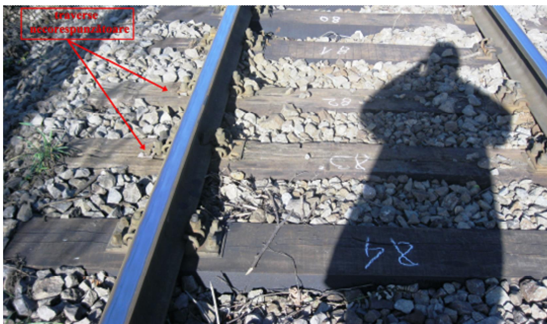
foto nr.3 - traverse necorespunzătoare între traverse noi
