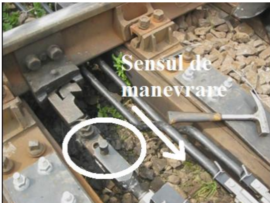
Foto nr.49- manevrarea din poziția intermediară către poziția de „PLUS”, bara de tracțiune se depărtează de bara de acționare și bolțul începe să coboare
