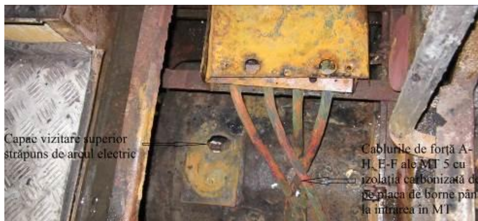
Fig.4 Capacul de vizitare al MT nr.5 și cablurile de forță
