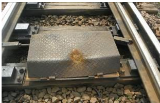
Fig. 3 Dispozitivul ajutător de manevrare cu arc (DAM) aferent macazului nr.3
