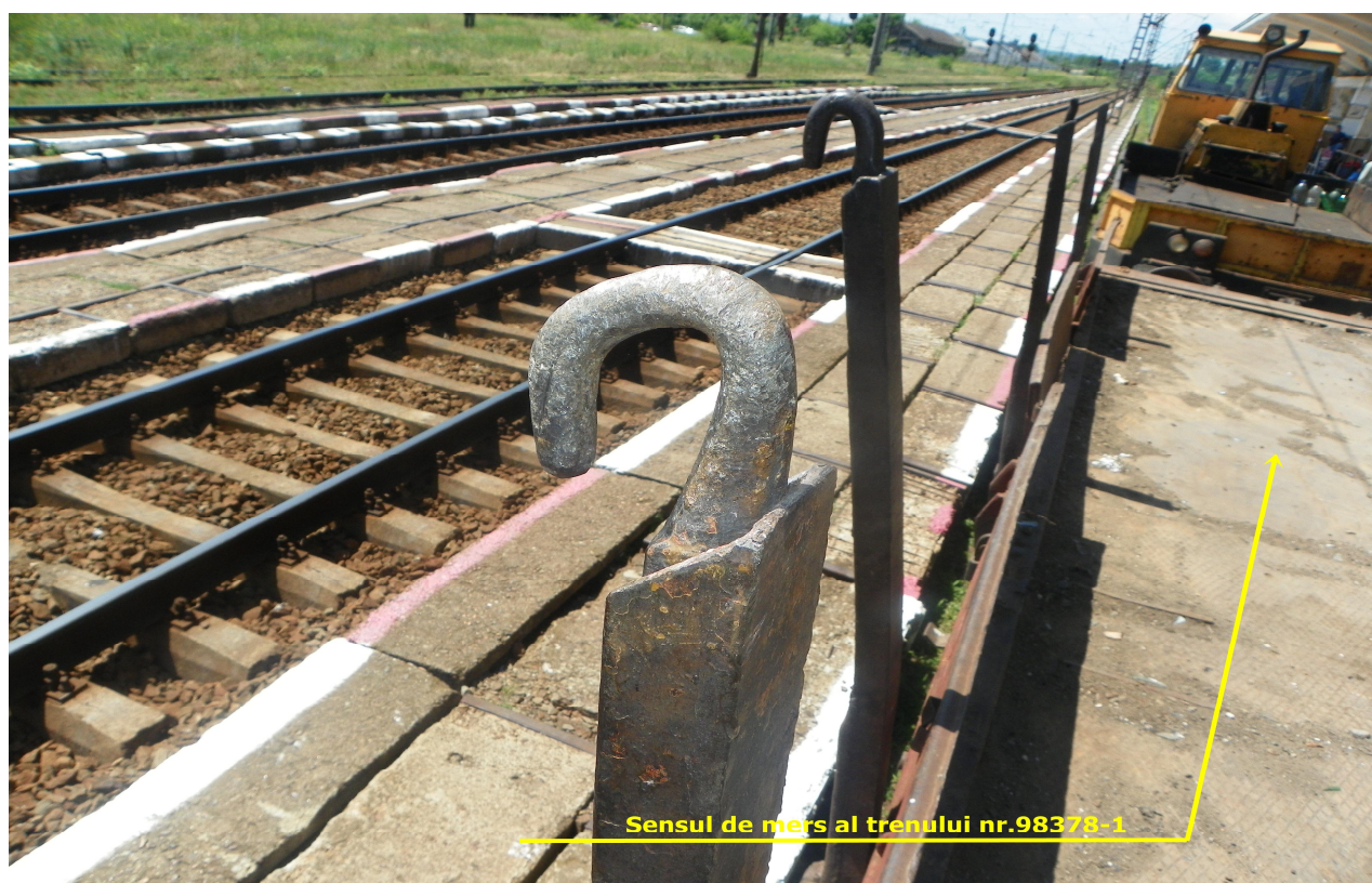
Fig. 7 Țepușa a-4-a pe partea stângă sens de mers cu urme de lovituri
