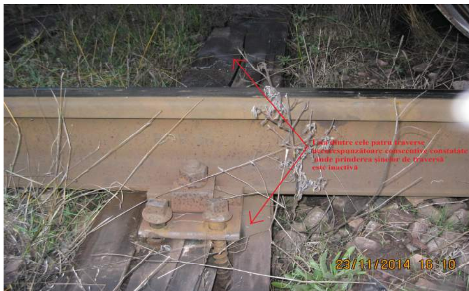
Foto nr.6 – traversă necorespunzătoare
