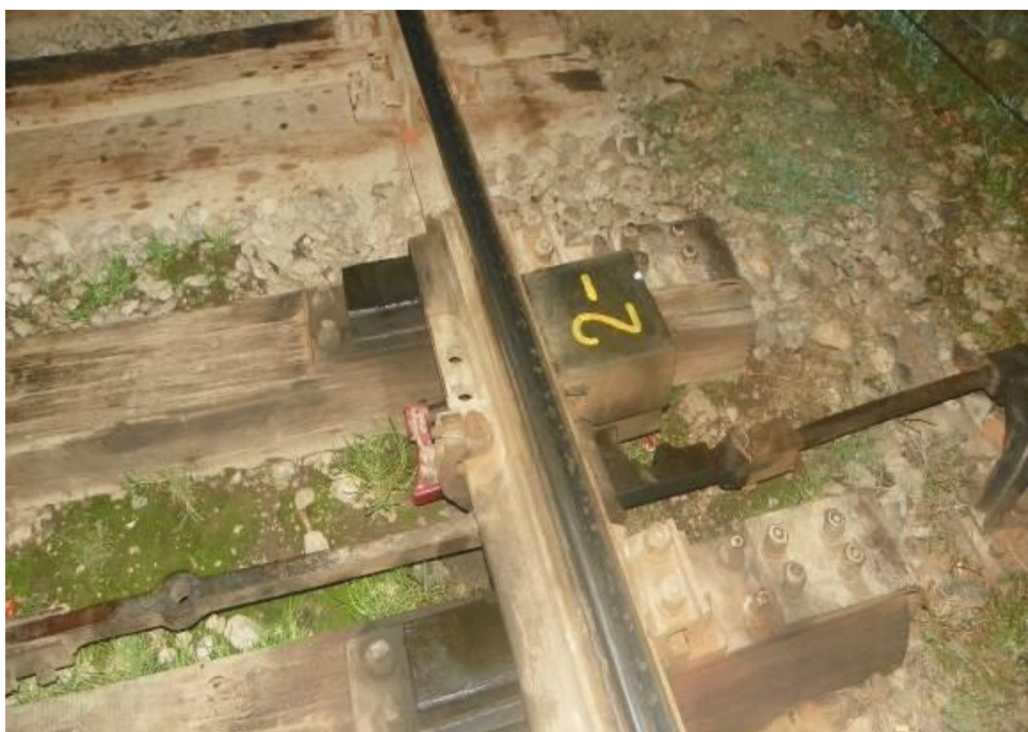
Fig.3 Încuietoearea în poziția „-” a macazului nr.2
