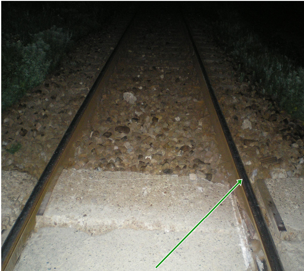
Foto 4 : Locul unde roțile boghiului deraiat s-au urcat înapoi pe calea de rulare
