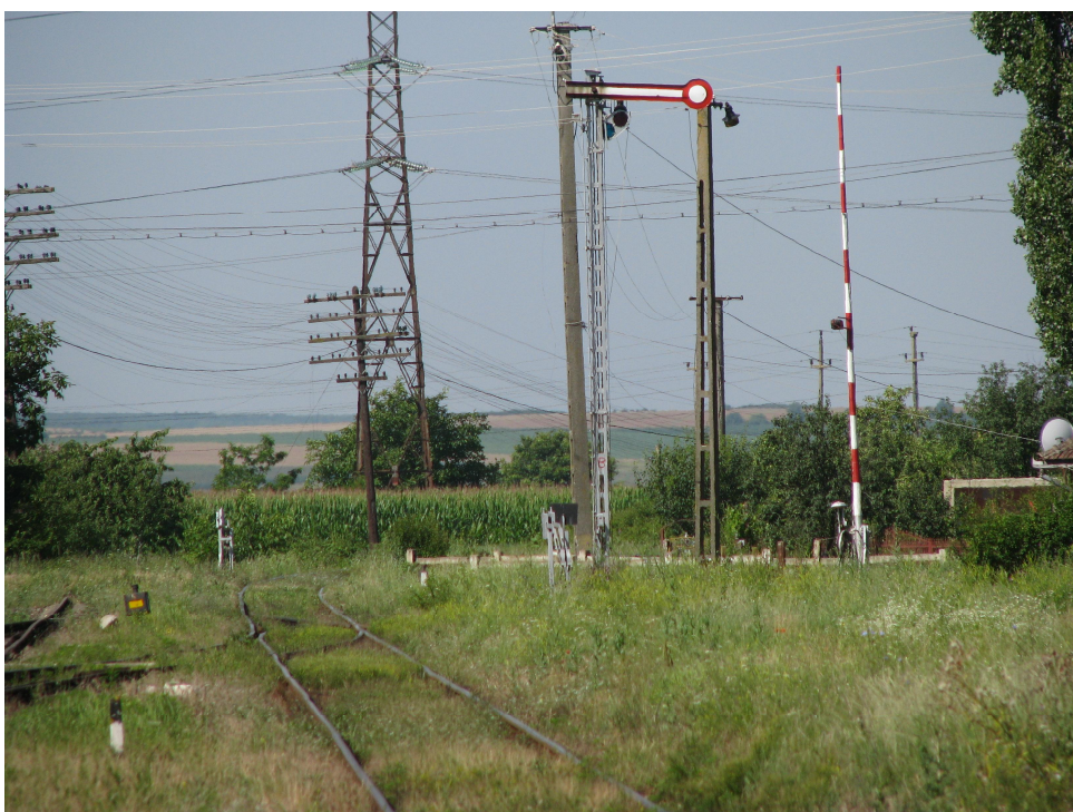
Figura nr.2 – Semaforul de ieșire depășit în poziție pe oprire
