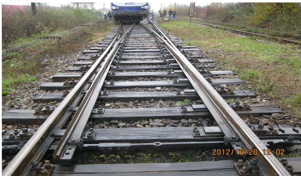
Fig.2. Macazul nr.6 pe poziția de acces la linia 4 abătută
