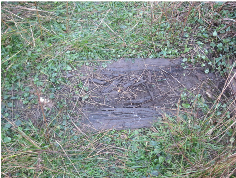
foto. nr. 5 – a doua traversă după punctul de cădere al roții din stânga
