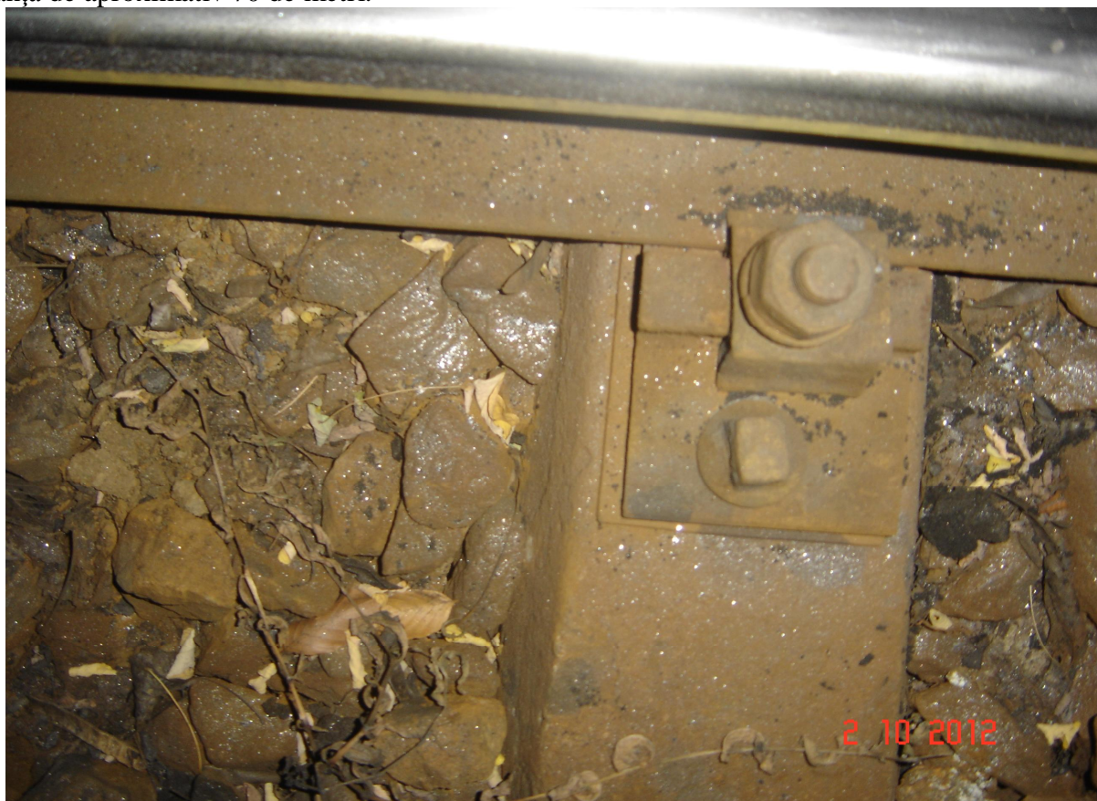
Foto 1. locul excluderii șinei de către roata din dreapta a primei osii de la locomotiva rotașă.
