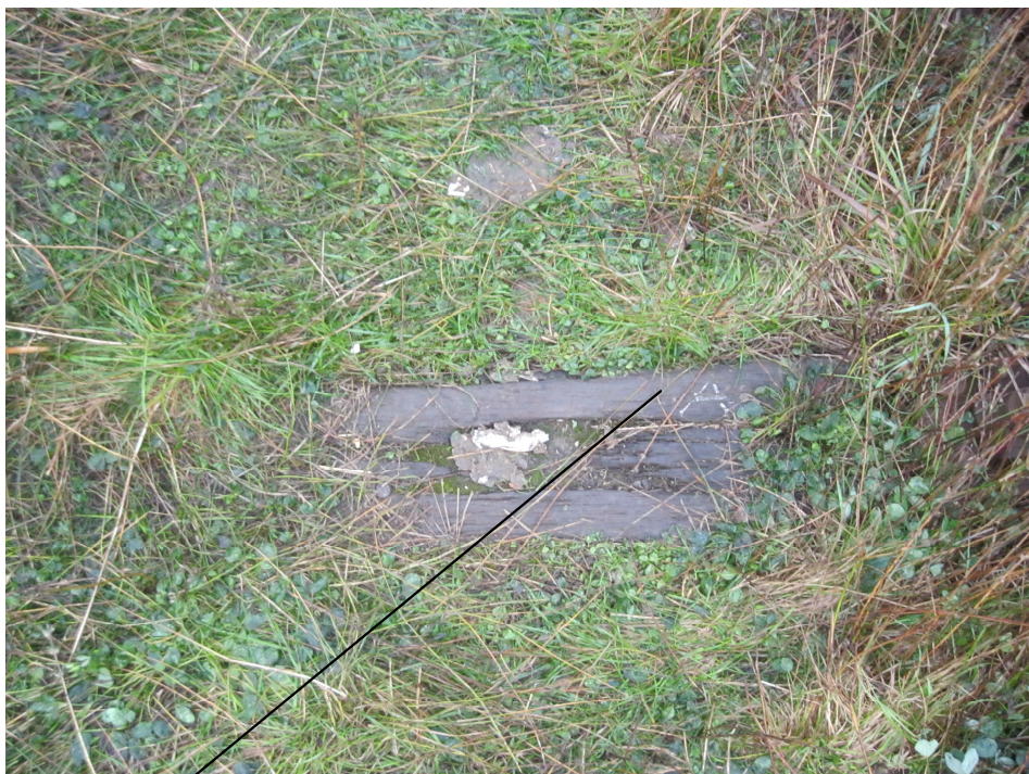
foto. nr. 4 – traversa din punctul de cădere al roții din stânga
