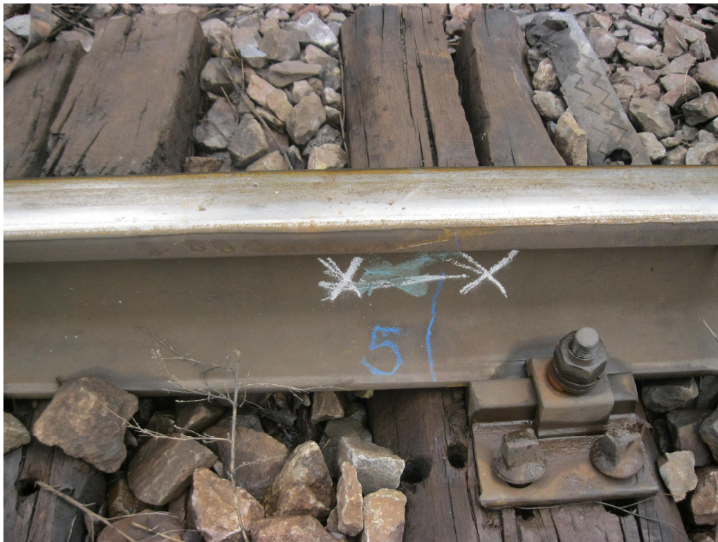
foto nr. 1 - urmele căderii roții din partea dreaptă între firele căii
