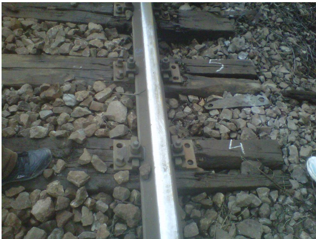
foto. nr. 6 – prinderi și traverse în locul producerii accidentului (traversa nr.5)
