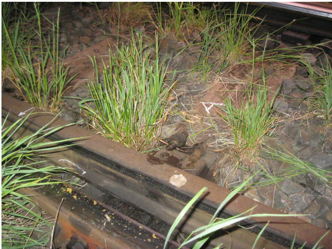
foto nr. 9 – traversa „A” cu cele două tirfoane cu ruptură veche 100 %
