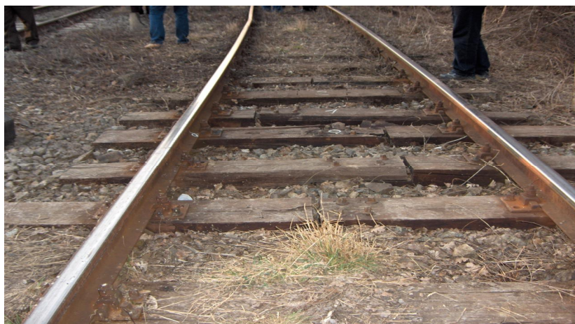
Foto 5 : Linia în zona deraierii și înădării traverselor
