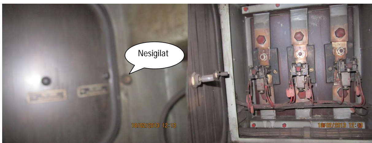
Fig.7 si 8 Releele maxime de curent 54
